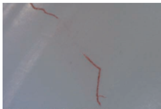
損傷部拡大(100倍)
